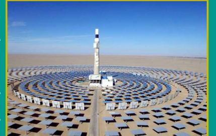
*Ci-dessus : la centrale solaire thermique de Shouhang Dunhuang dans le désert de Gansu en Chine a une puissance de 10 MW et une capacité de stockage de 15 heures lui permettant de fonctionner 24h/24.*
